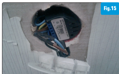
Les micromodules se placent facilement dans les boîtes d'encastrement
