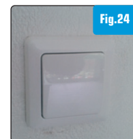
Interrupteur Z-Wave installé
