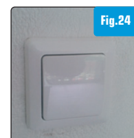
Interrupteur Z-Wave installé
